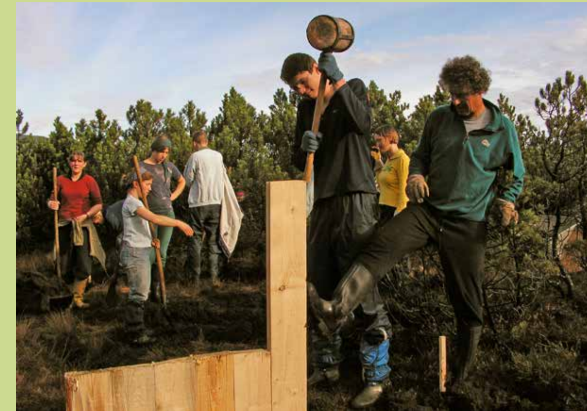
Senkrecht eingeschlagene Nut- und Federbretter stauen die Entwässerungsgräben auf.
