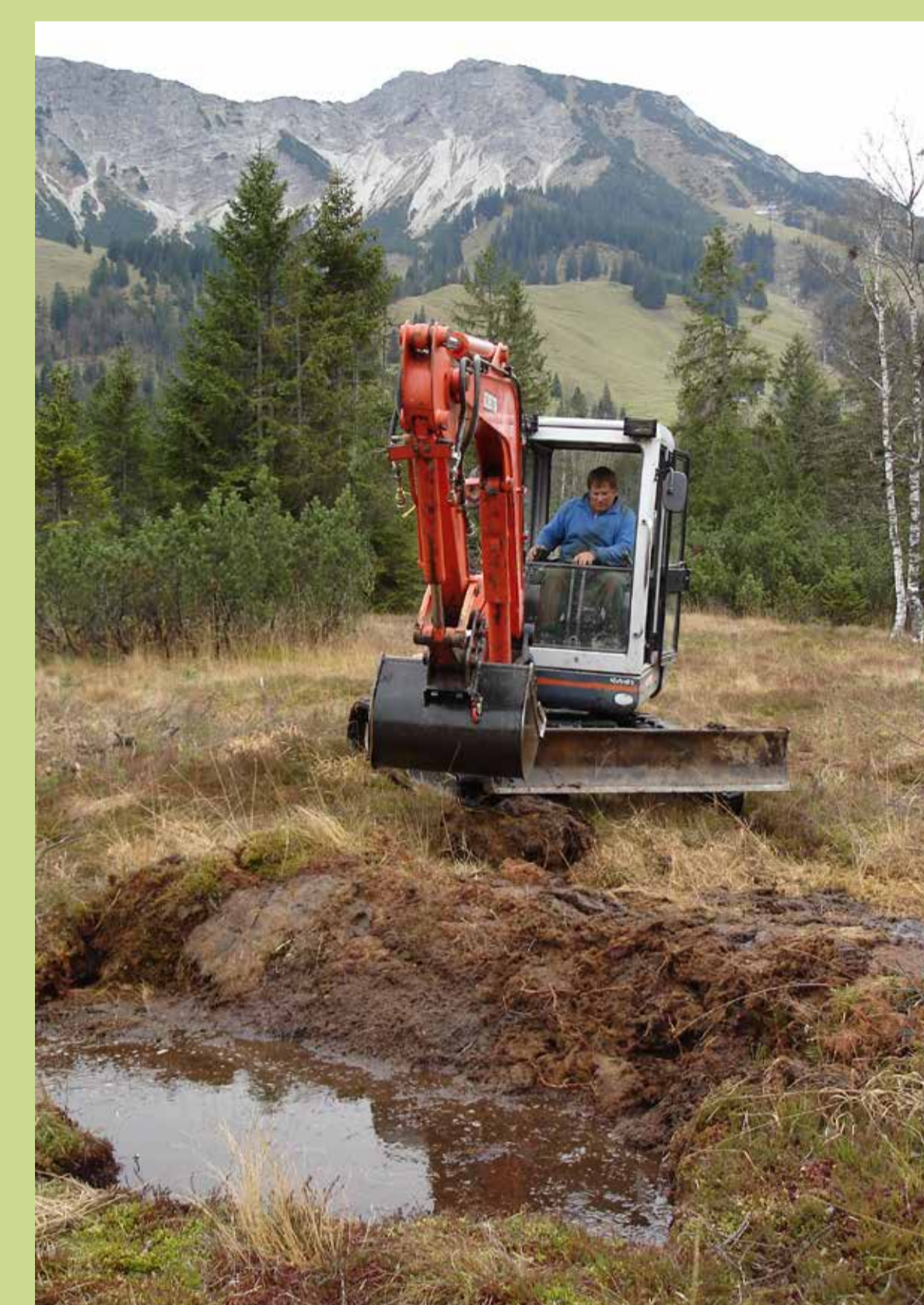
Bei den Staumaßnahmen zur Wiedervernässung kam ein Bagger zum Einsatz.
