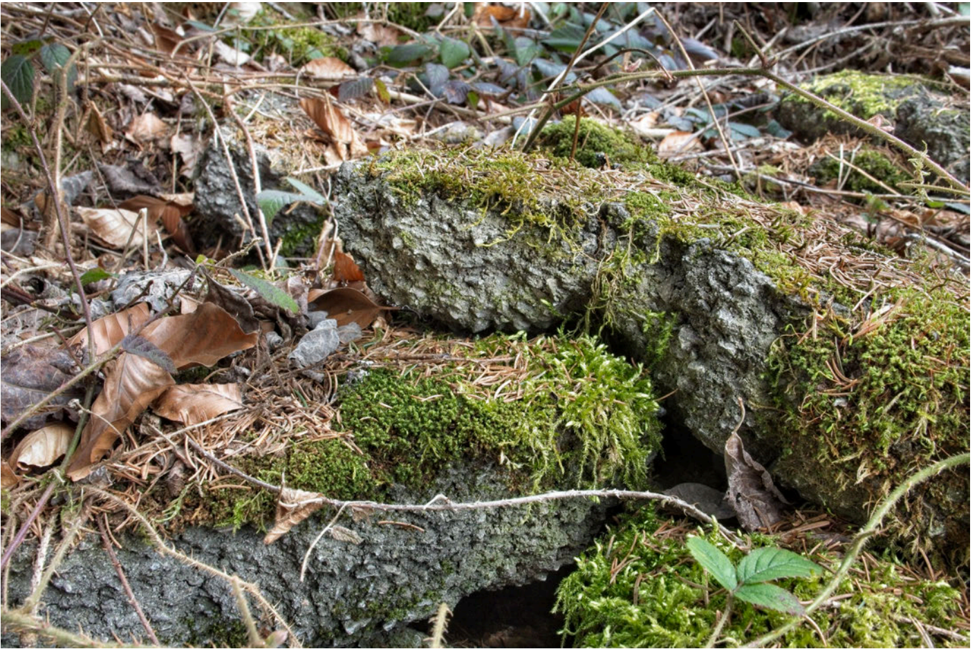
Abb.7 Betonbruch in der westlichen Waldrandzone der Aufschüttung 2
