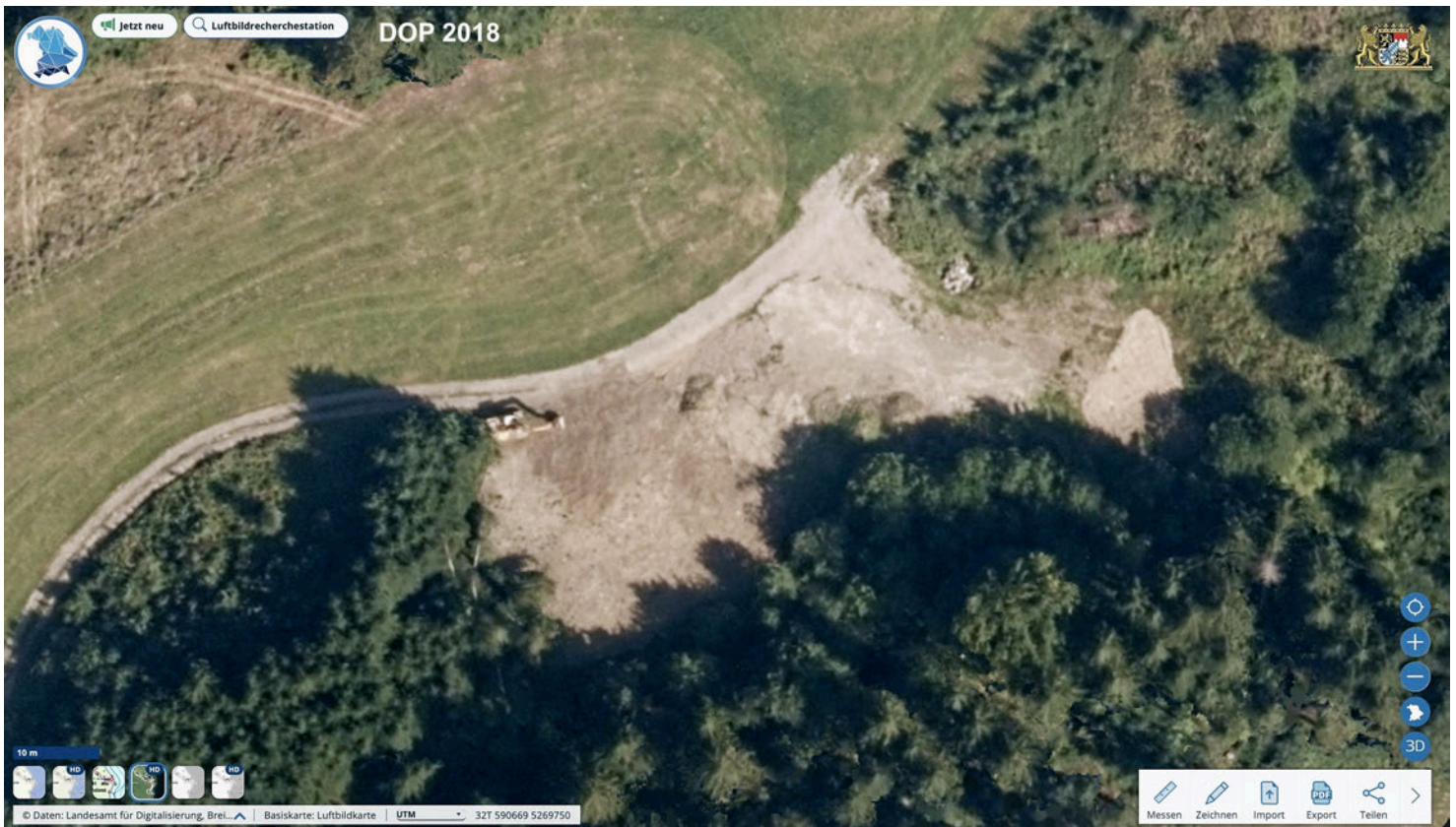
Abb.11 Digitales Orthophoto aus dem Bayernatlas. Überflug am 16.8.2018. Bereich der Aufschüttungszone 1. Bagger und bearbeiteter Boden sind deutlich zu sehen.
