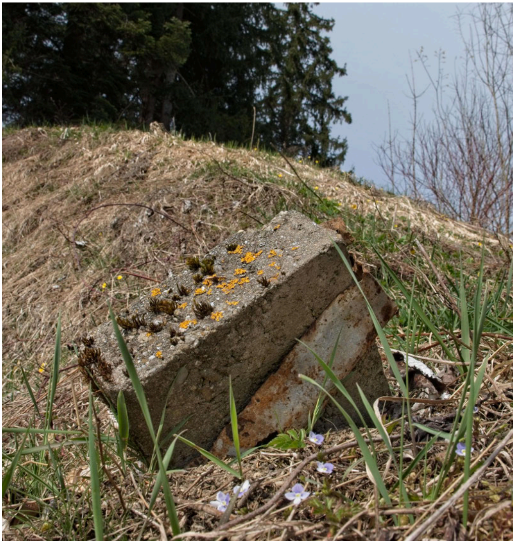
Abb.6 Betonstein und Eisenschrott
