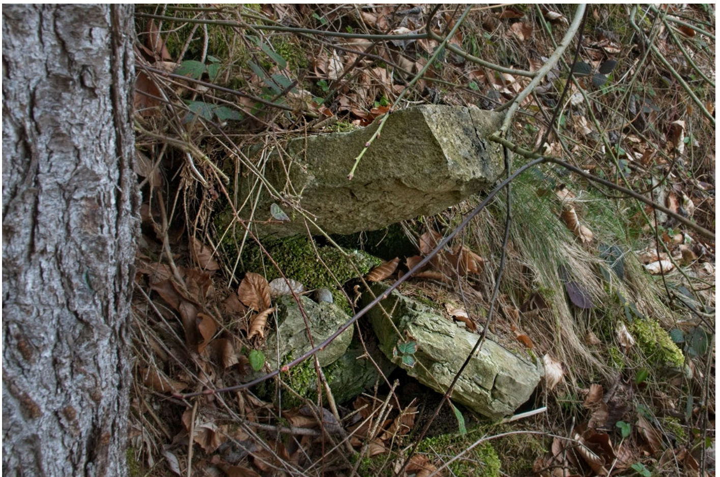
Abb.8 Stein- / Mauerteile im westlichen Waldrand der Aufschüttung 2
